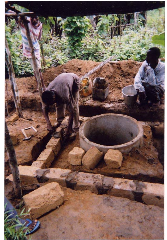
Libéria : creusement d'un puits profond étanche
