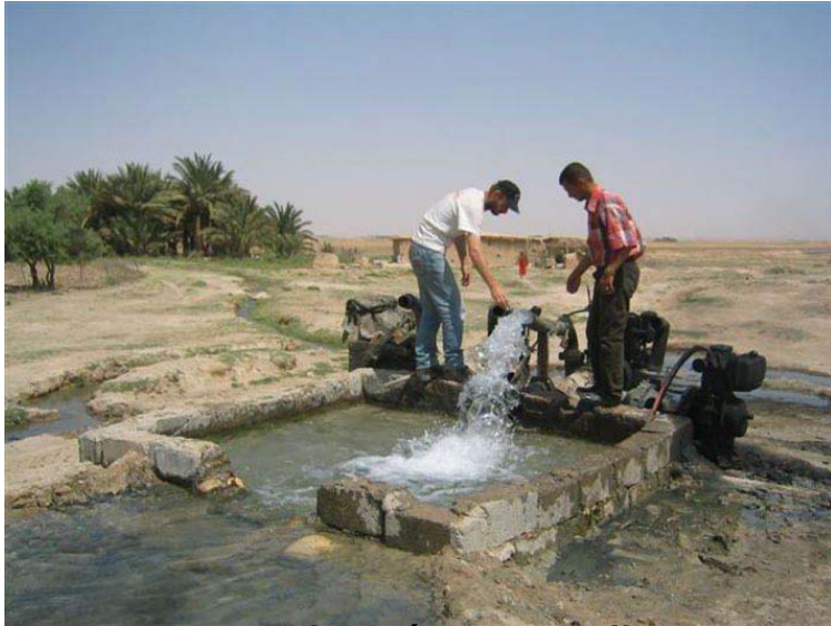
Irak: aménagement d'une pompe
