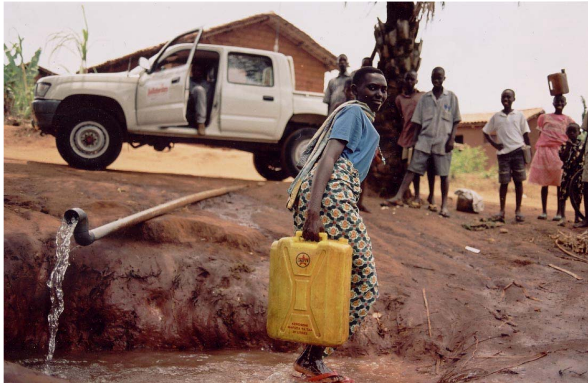
Burundi : point d'eau potable en cours d'aménagement
