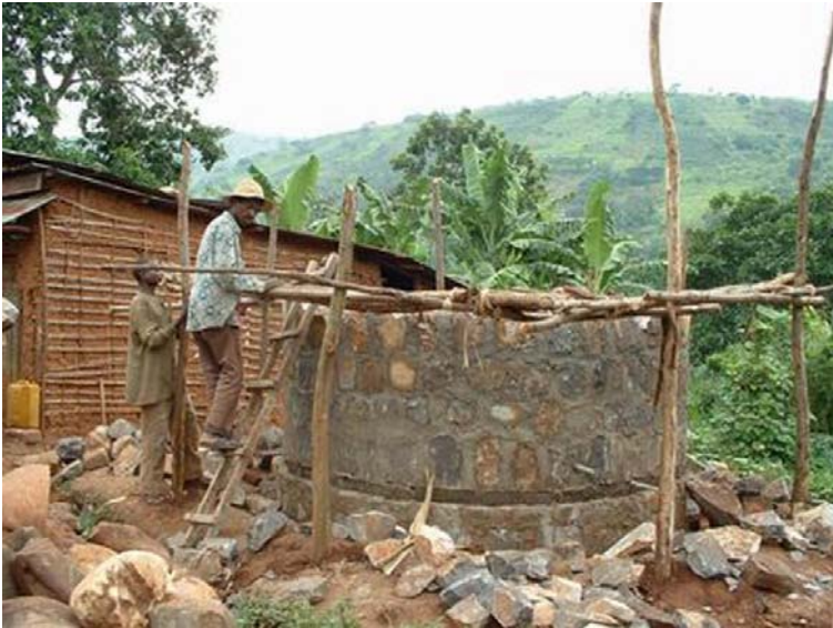
Burundi: puits en construction
