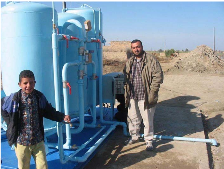
Irak: réhabilitation d'une station de traitement des eaux
