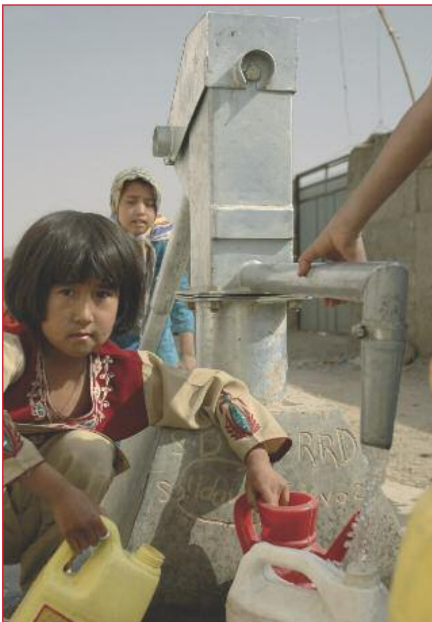
Pompe à main installée par SOLIDARITES à Kaboul
