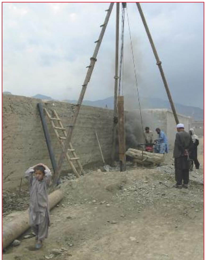
Forage profond réalisé par SOLIDARITES à Kaboul
